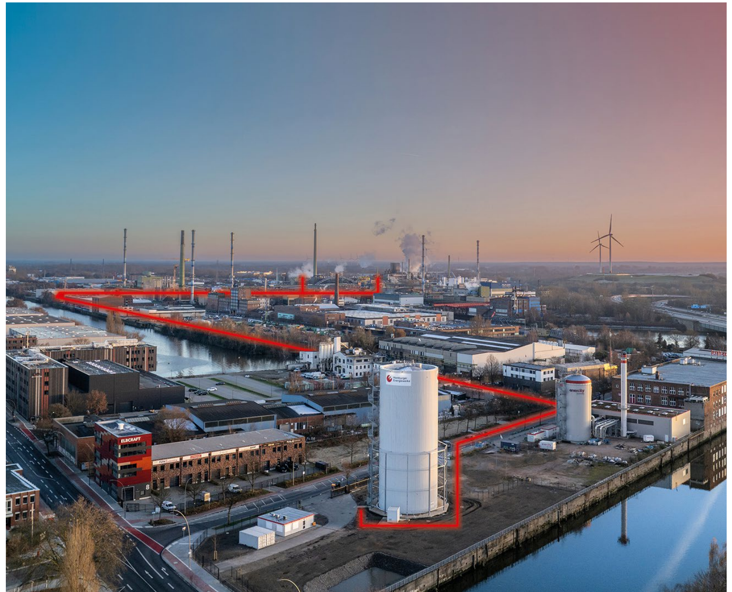
Abb. 2.17: Verlauf der Fernwärmetrasse vom Aurubis-Werk
