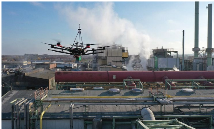
Emissionsmessungen mittels Drohne im Werk Lünen
