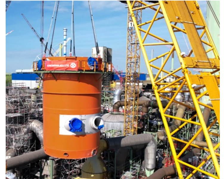
Umbau der Kontaktanlage im Industrierwärmeprojekt
