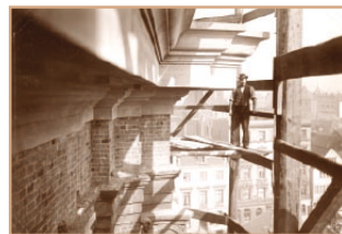
Ein Handwerker beim Wiederaufbau der Kirche im September 1907.
