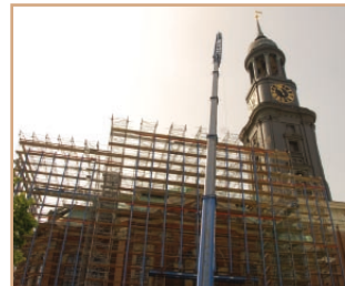
Seit Ende Mai 2008 umgibt den Michel ein riesiges Gerüst.
